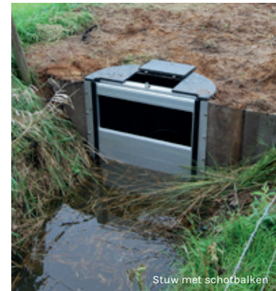
Stuw met schotbalken
