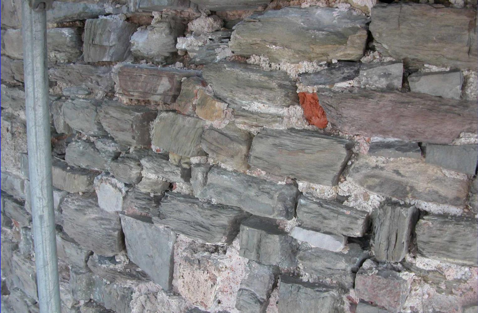
Mörtelentwicklung: für Grauwackemauerwerk
